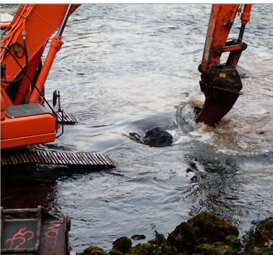
Ripper i aksjon i Aurland. Elvebunnen løsnes og renses. Foto: Ulrich Pulg
